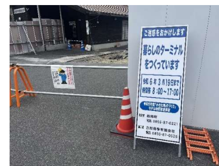
ターミナルの工事もはじまっています！
